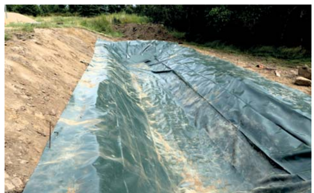
Verlegen der Folie
