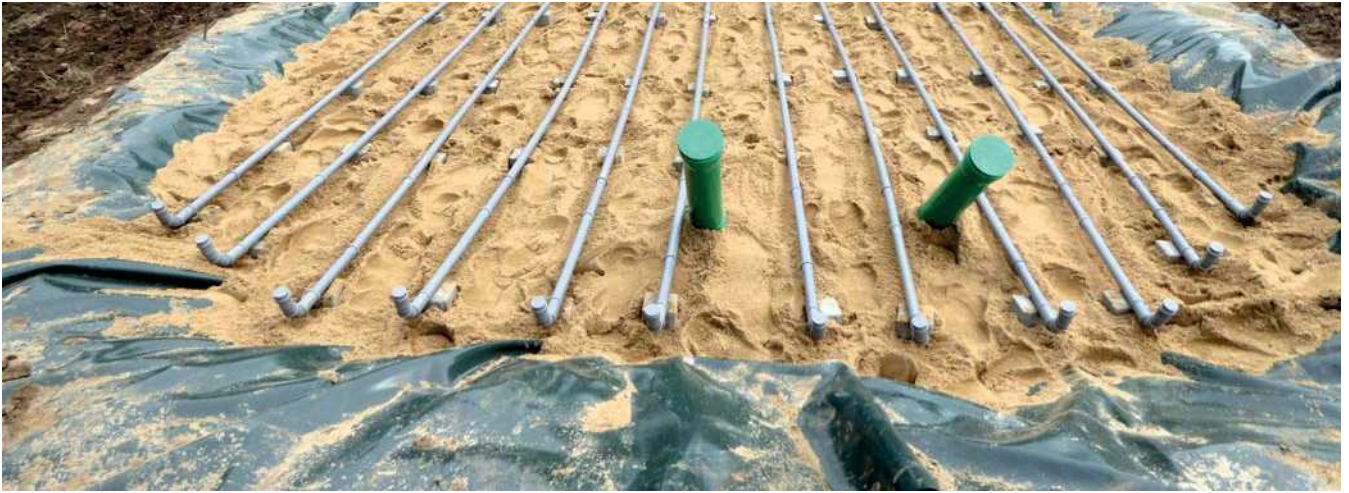
Beschickungsrohre und Revisionsöffnungen der Dränung
