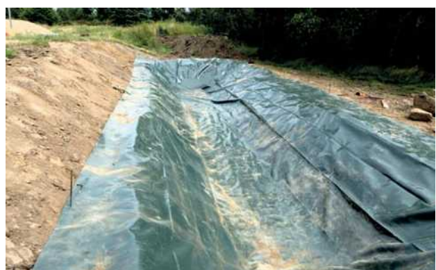
Verlegen der Folie
