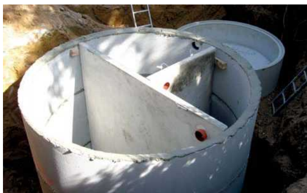
Mehrkammergrube als Vorklärung
